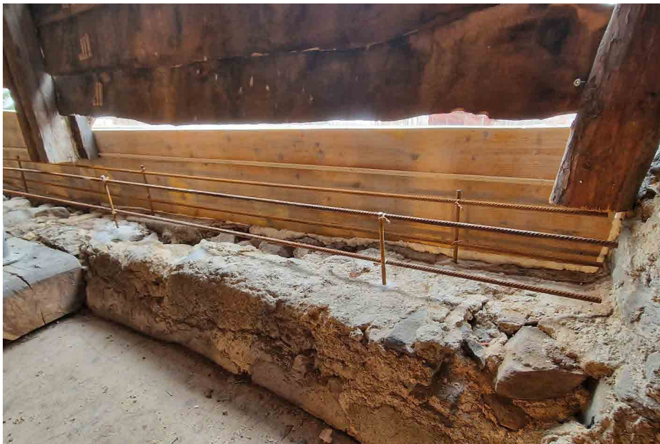
Vorbereitet für den Betonriegel 22.12.2022
