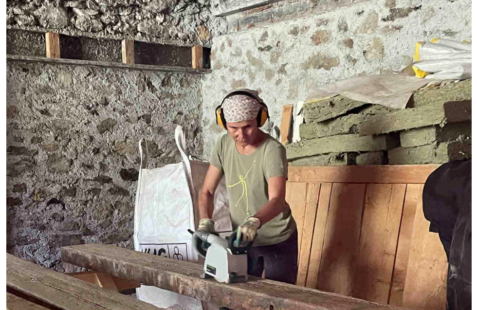
Die Balkenbürstmaschine im Einsatz
