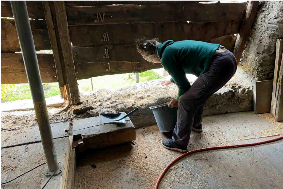
Vorbereitungen für den Betonriegel 22.10.2022
