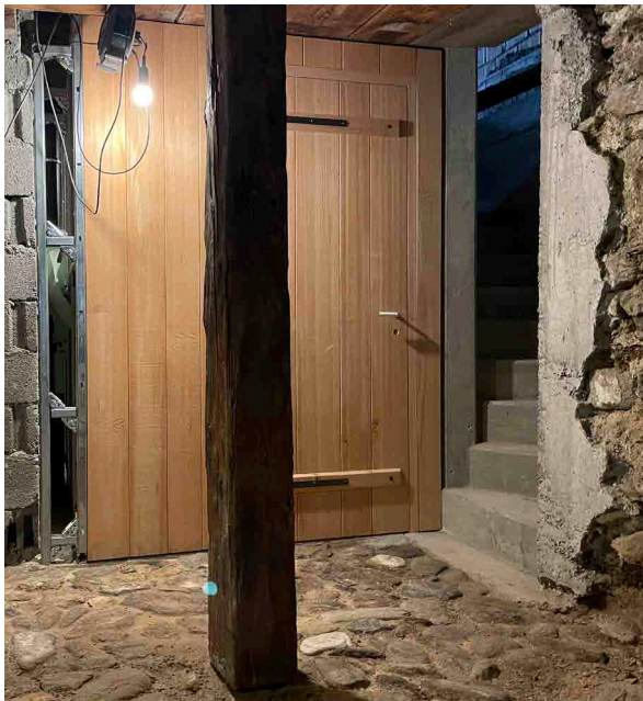
Das Bau-WC bekommt eine Türe 07.10.2022
