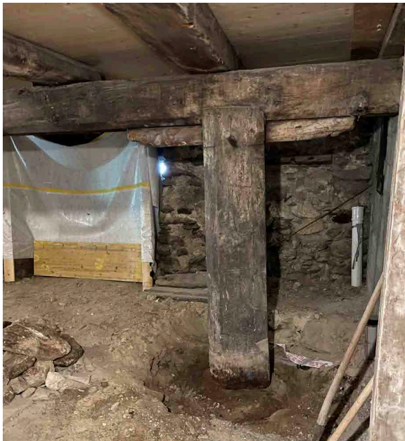
Die Stütze wird trocken gelegt 22.06.2022
