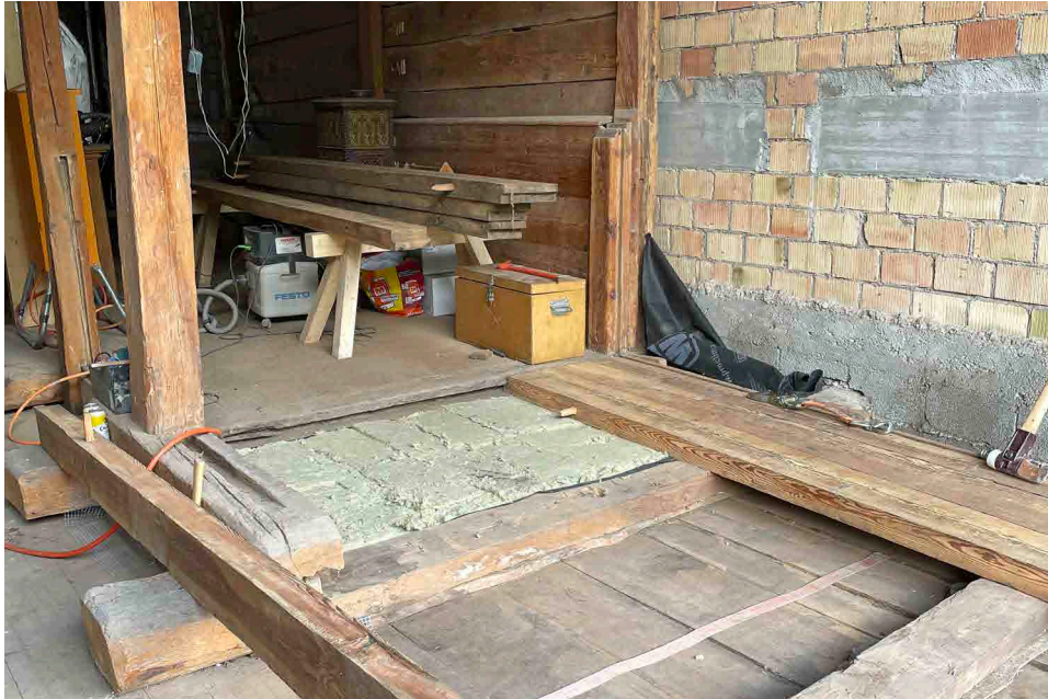
Das erste Bodenfeld wird isoliert 15.08.2022
