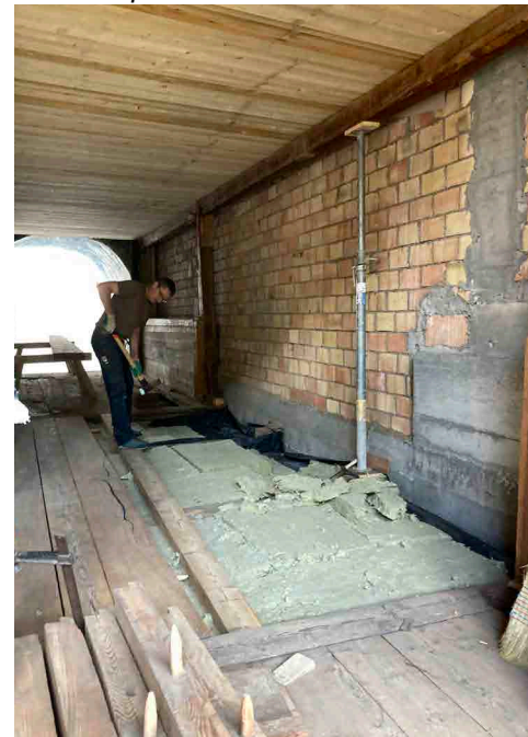
Dämmung Boden EG 28.05.2023
