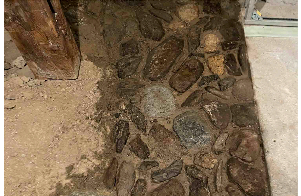
Flusskieselsteinboden im Stall 21.08.2022
