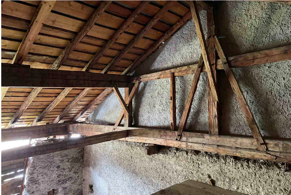
Ansicht Dachstuhl auf Höhe Studio 05.03.2022
